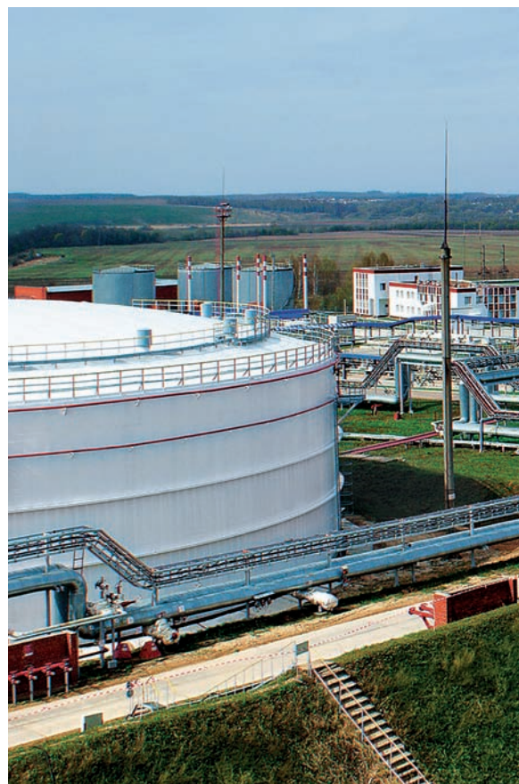
НПС «Горький-2» ОАО «Верхневолжскнефтепровод»
