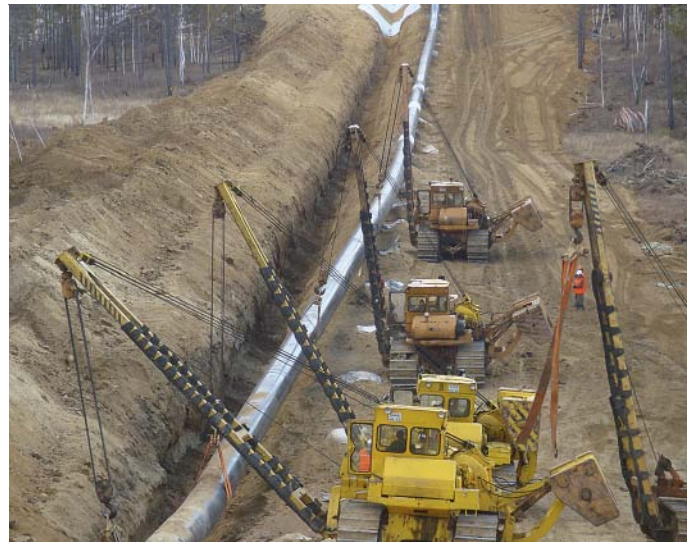
Строительство линейной части БТС-2
