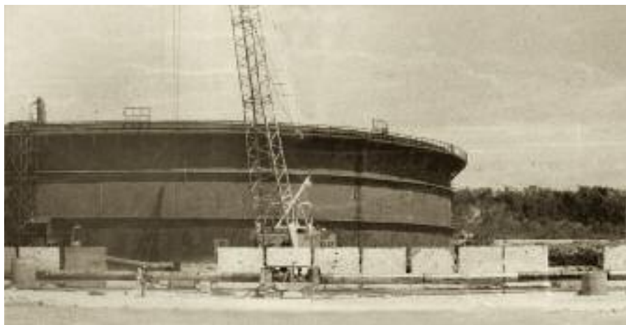
Монтаж резервуара-пятидесятитысячника на нефтебазе «Матансас» (Куба)
