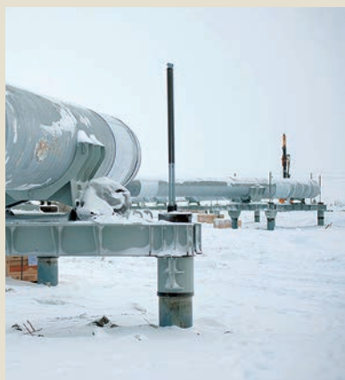
Рис. 8 Система геотехнического мониторинга ТС Заполярье – НПС «Пурпе»
